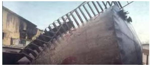
Danni alla copertura di un serbatoio nel terremoto di Landers – California del 28/06/1992
