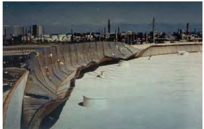
Danni alla copertura di un serbatoio nel terremoto di Landers – California del 28/06/1992
