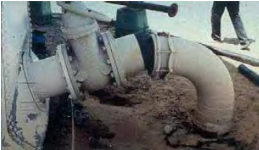
Figura 4 – Rottura tubazione
