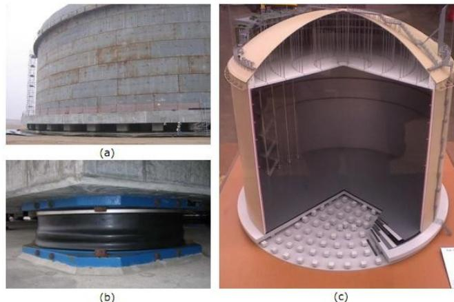
*Pampa Melchorita (Perù): (a) uno dei due serbatoi per lo stoccaggio di LNG da 130.000 m<sup>3</sup> sismicamente isolato con (b) tripli pendoli a scorrimento; (c) modello del serbatoio*
