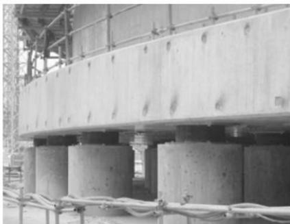
Alcuni dei 360 isolatori HDRB, di 700 mm di diametro, installati in uno dei 3 serbatoi LNG costruiti nella Provincia di Guangdong, nella Cina Meridionale (tali serbatoi hanno 84 m di diametro, 39 m d'altezza e pesano, quando pieni, 140.000 t)
