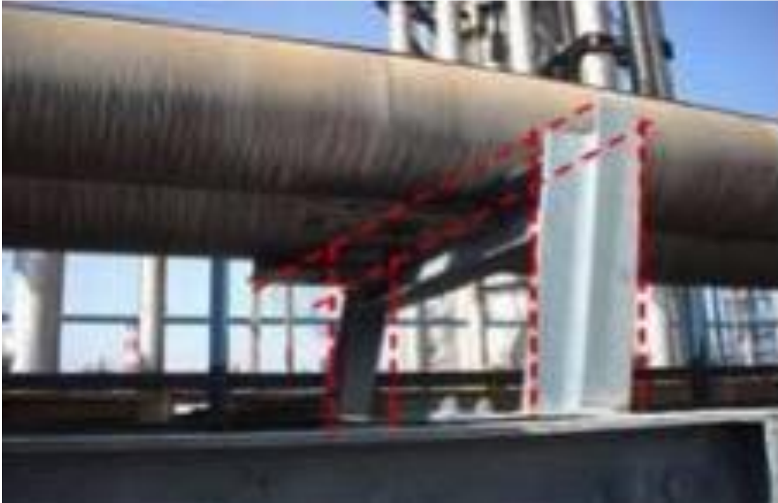
Supporti danneggiati durante il sisma tellurico
