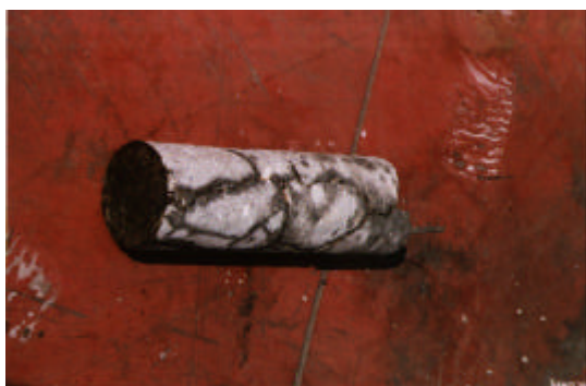
Figura 8: carota estratta da pilastro danneggiato Capannone industriale in Prato
