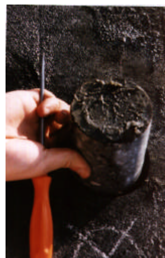
Figura 7: estrazione carota da pilastro – Prato
