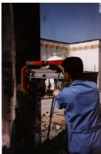
Figura 5: fasi di carotaggio capannone in Prato
