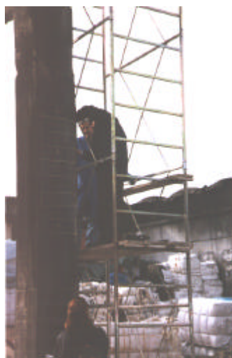
Figura 6: estrazione carota da pilastro – Prato
