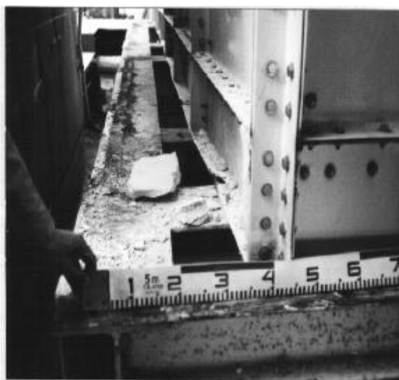
Fig. 14 Spostamento di un componente massiccio sul blocco di base nell'ospedale a Kobe
