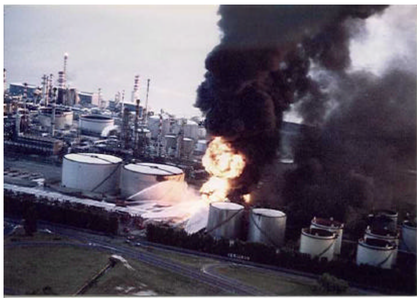
Fig.2 – l'incendio si propaga a due serbatoi a tetto galleggiante
