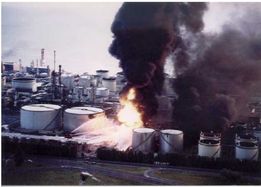
Fig.1 – le prime fasi dell'incendio
