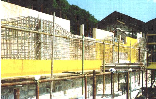
Figura 16. Armatura della lastra in c.a.
