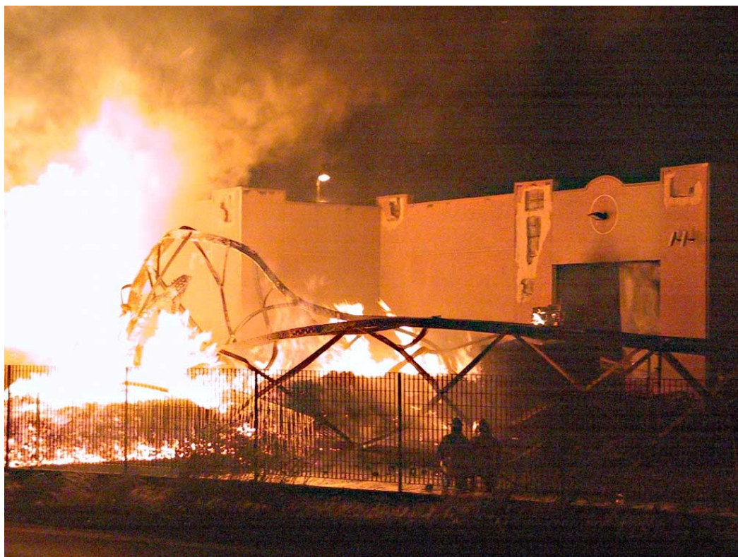
Figura 1. Incendio di un deposito bancali a Brembate (BG) il 5.5.2003.
