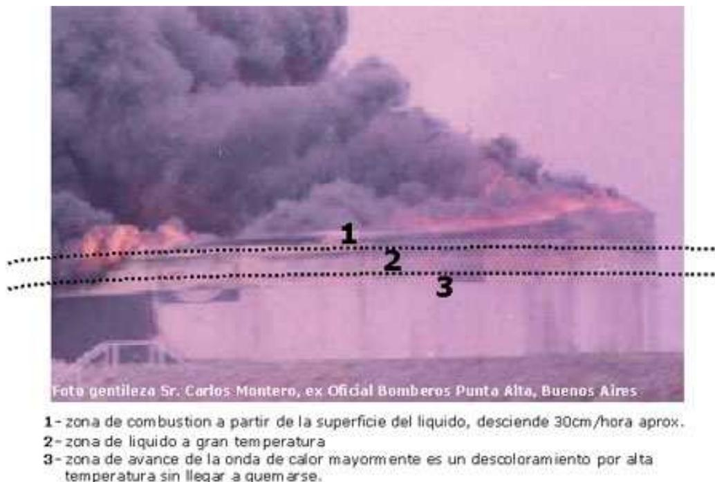
Figura 5. Onda di calore prodotta durante l'incendio di un serbatoio
