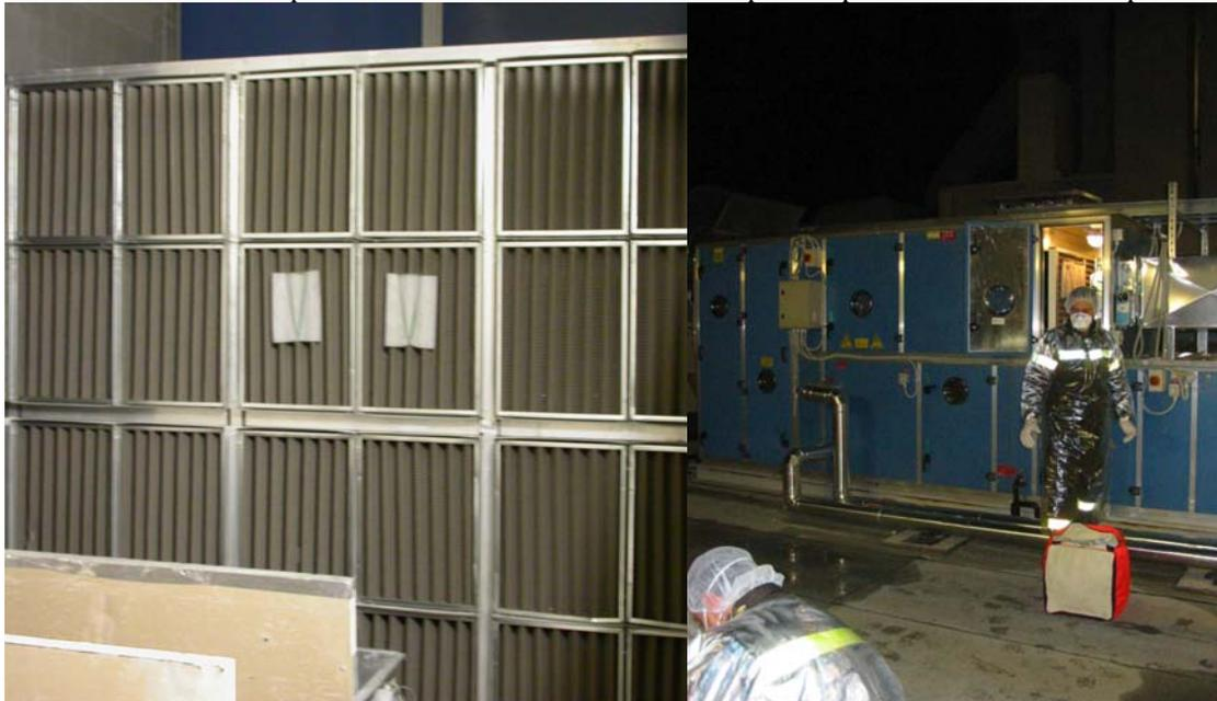
Figura 1. I dispositivi di campionamento posizionati all'interna di un UTA (a sin) e Operazioni di campionamento sulle UTA (a dx)
