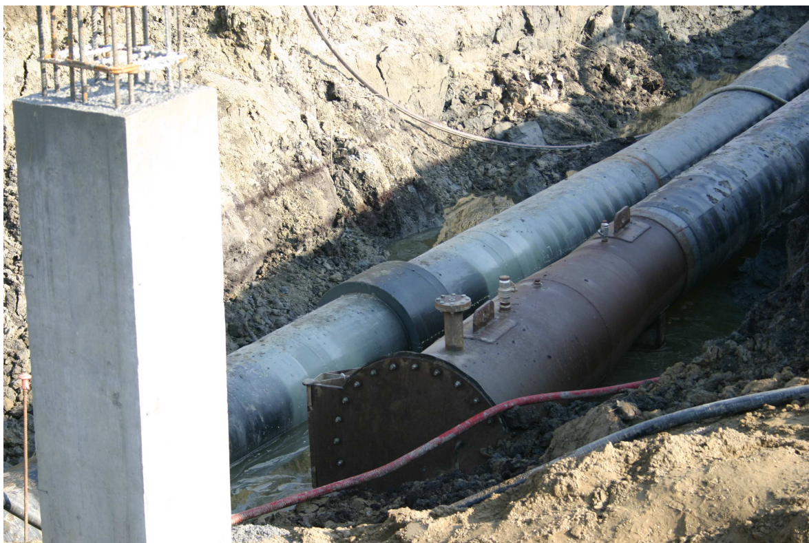
Figura 8. Posizionamento delle tubazioni (si notino il giunto dielettrico e la tubazione di trasporto del cavo in fibra ottica)
