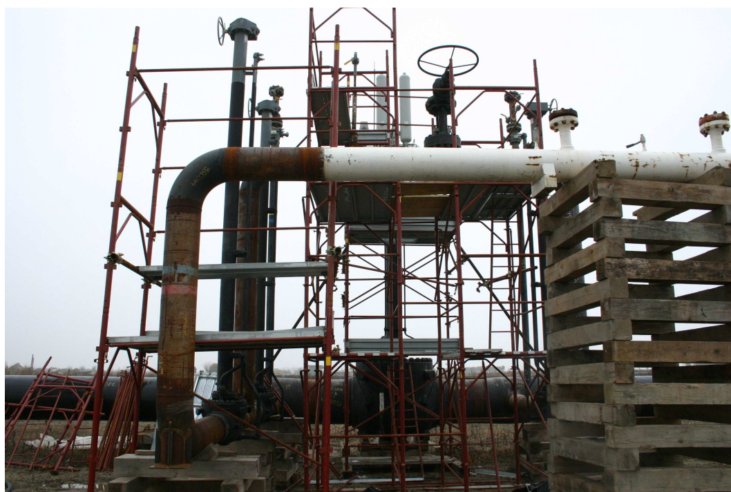
Figura 11. Collaudo idraulico della valvola prima del suo interrimento
