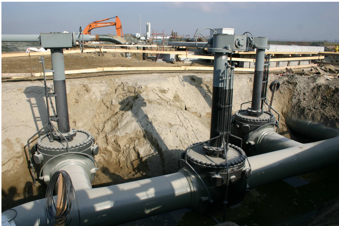
Figura 7. Posizionamento di valvole per il sezionamento
