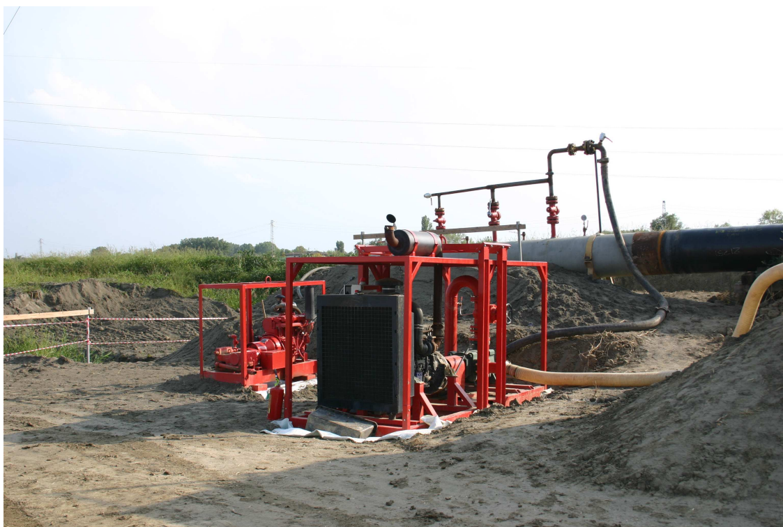
Figura 9. Motopompa per la prova idraulica
