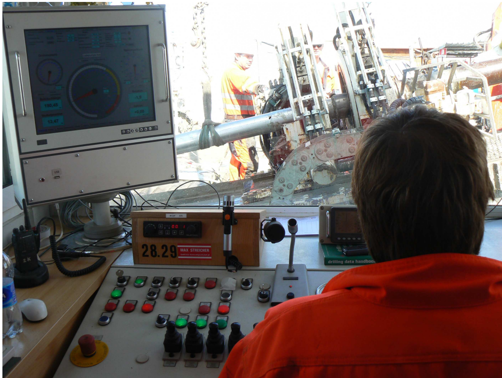
Figura 6. Sala controllo della Trivellazione Orizzontale Controllata (monitoraggio in particolare degli sforzi, della direzione e della profondità raggiunta dalla trivella).
