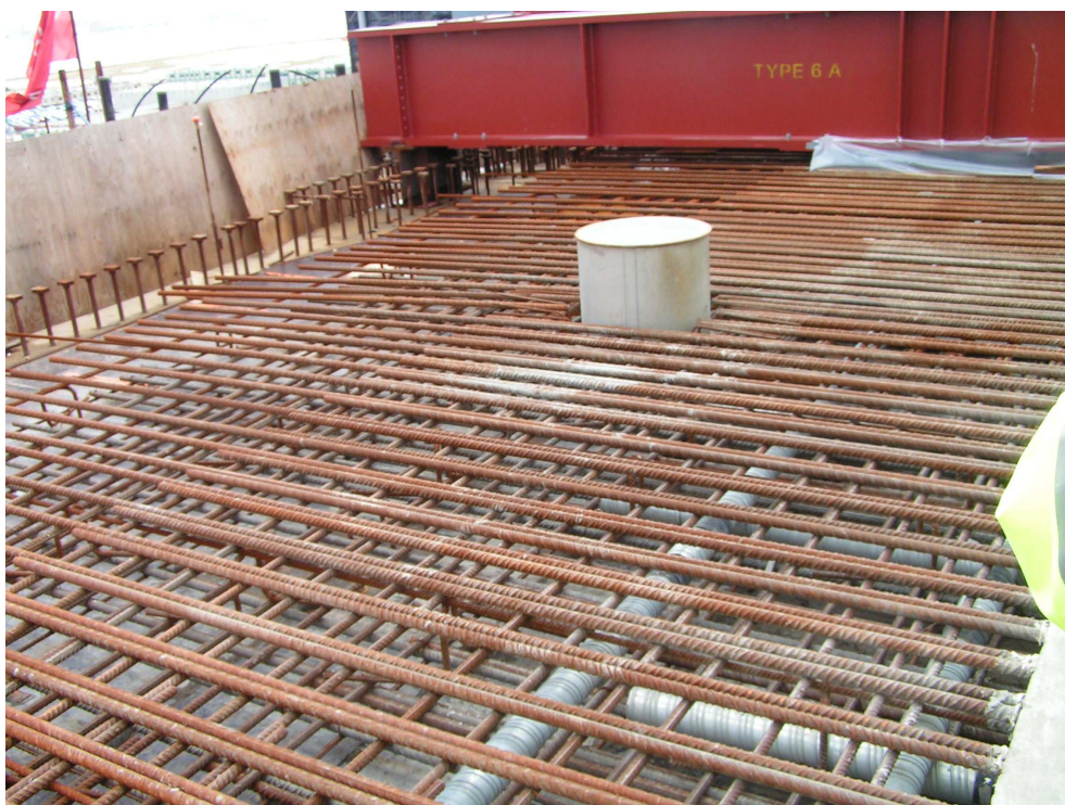
Figura 2. Visione di parte delle armature utilizzate nel GBS.
