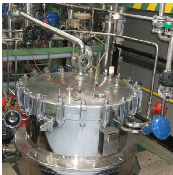
Figura 2. Testa del reattore
