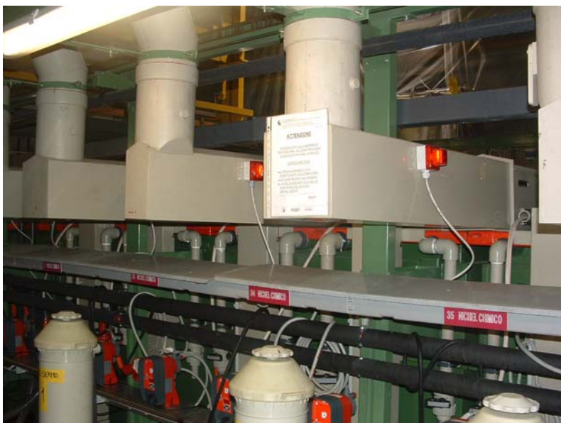
Figura 5 Inserimento delle spie luminose
