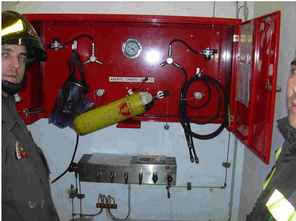
Figura 3. Il pannello per la ricarica delle bombole d'aria compressa.
