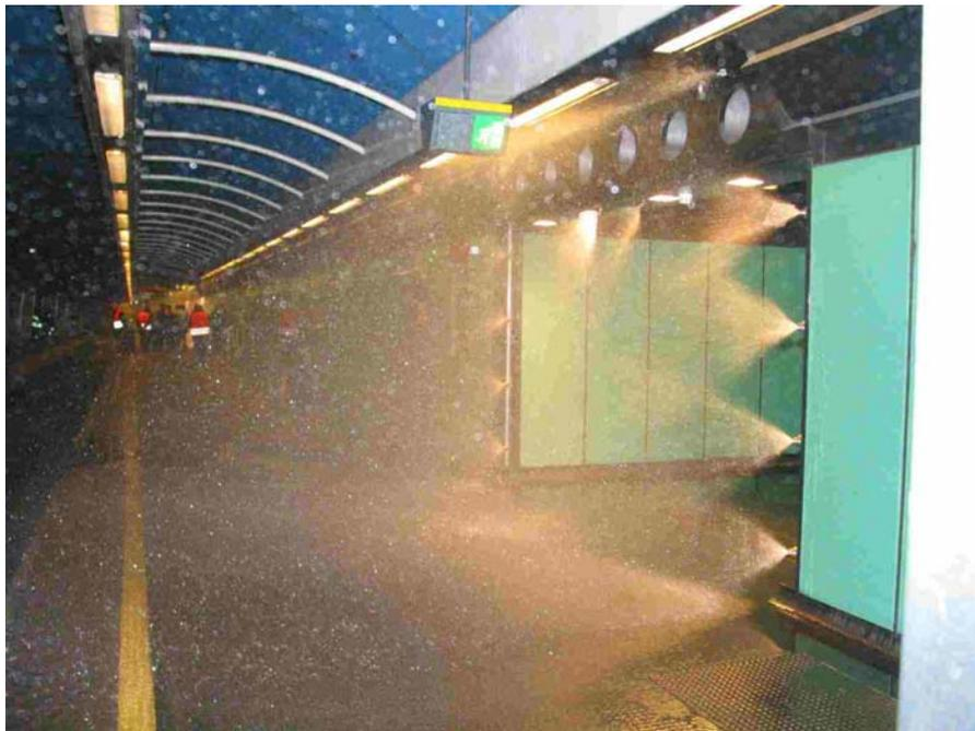
Figura 4. Il sistema di compartimentazione delle banchine a “veli d'acqua”.
