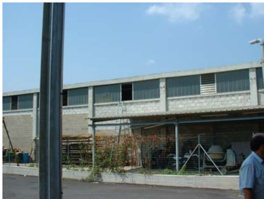
Foto n.16. Sequenza (in senso orario) della foto n. 15. Si noti l'assenza di danni in questa costruzione posta sul lato opposto della tettoia.
