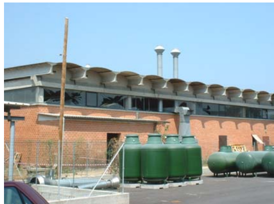
Foto n.17. Sequenza (in senso orario) della foto n. 16. Ancora rottura vetri in fabbricato esterno, posto lato opposto rispetto al termocombustore (per propagazione dell'onda d'urto attraverso il fabbricato interno adiacente al termocombustore).
