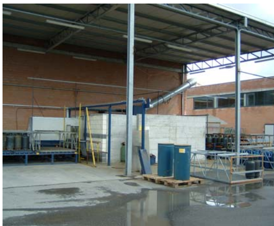
Foto n. 22. Muri di schermo delle macchine di svalvolamento e lavaggio dei bidoni.
