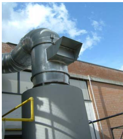
Foto n. 23. Dettaglio della valvola a clapè posta sul serbatoio D-1.
