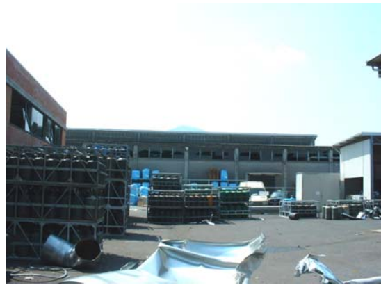
Foto n.15. Sequenza (in senso orario) della foto n.14. Si noti la rottura dei vetri anche nel capannone sullo sfondo, all'esterno del perimetro aziendale.
