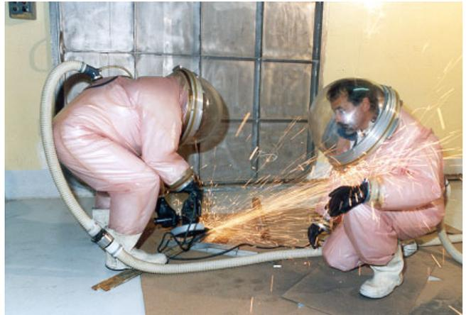
Fig. 6 Operatori con scafandro ventilato Scalh ne
