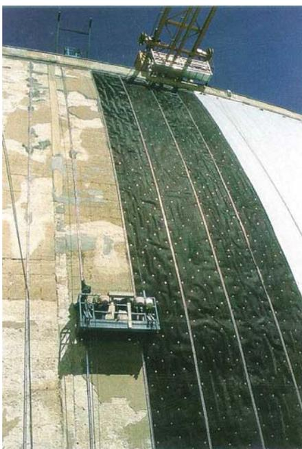
Fig. 2.8 - Interventi di ripristino della tenuta del paramento di monte su dighe in calcestruzzo, mediante geomembrane in PVC.
