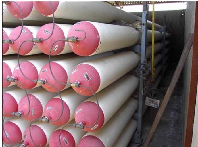
Figura 6. Deposito di idrogeno compresso in uno stabilimento industriale ubicato nella provincia di Cuneo.
